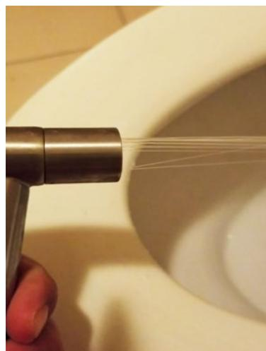
安装前：用来冲洗卫生间的水枪已经被水垢堵塞了大约2/3的部分
