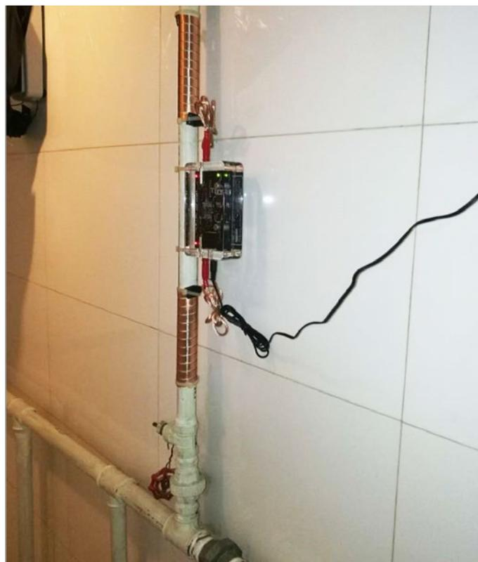
Vulcan 3000 a été installé sur une conduite d'eau solaire en vue d'éliminer les problèmes de calcaire dans les tubes à vide.
