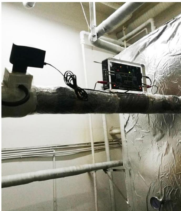
Vulcan S10 a été installé en face de l'échangeur de chaleur afin de résoudre les problèmes de calcaire présent dans les échangeurs de chaleur, pompes, réservoirs d'eau, têtes de douche et dans le système de tuyauterie général.
