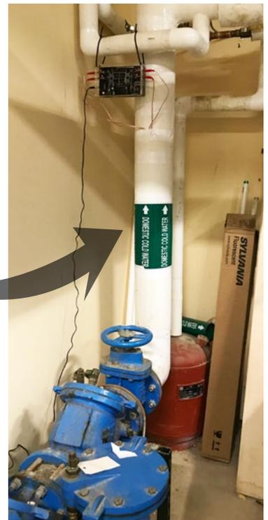
Étape 2 : Installer l'unité S25 sur la conduite d'eau principale et remettre la couche isolante
