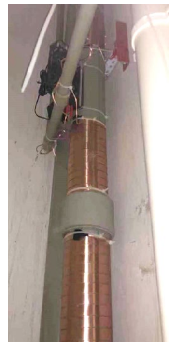
Equipo Vulcan S50 instalado en la tubería de agua principal
