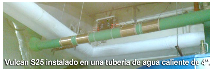
Vulcan S25 instalado en una tubería de agua fría de 4".
