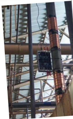
Vulcan S25 è stato installato circa 50 metri a monte della macchina per la tempra a induzione.
