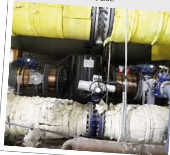
Fase 2: installazione all'esterno, tubo avvolto in cotone isolante, unità X-Pro 2 scatoletta di protezione
