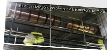
Fase 1: installazione dei cavi per la trasmissione di impulsi
