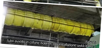
Fase 2: tubo avvolto in cotone isolante, poi installazione unità X-Pro 1
