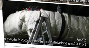
Fase 2: tubo avvolto in cotone isolante, poi installazione unità X-Pro 1
